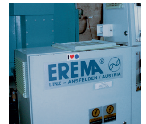
Seit 12 Jahren bei Inter-PET im Einsatz: EREMA Schaltkasten mit Siemens Control.
