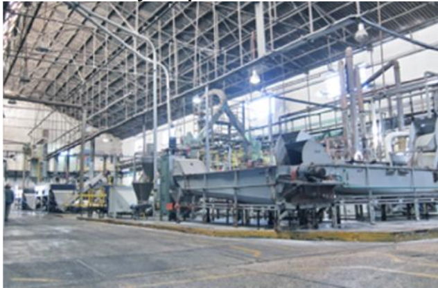
Die Recycling- und Produktionshalle von RECICLAR
